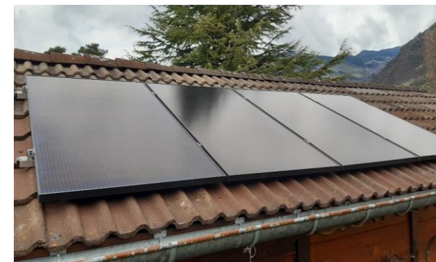
Kit de 4 modules (2000 Wc) monté en portrait sur toiture
